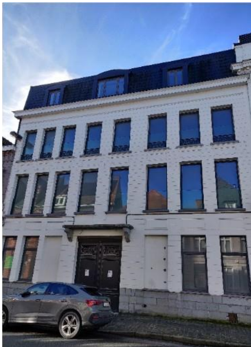
Façade de l'immeuble au n°6 de la rue St Jacques (Photo Baudouin Desclée 2026)
