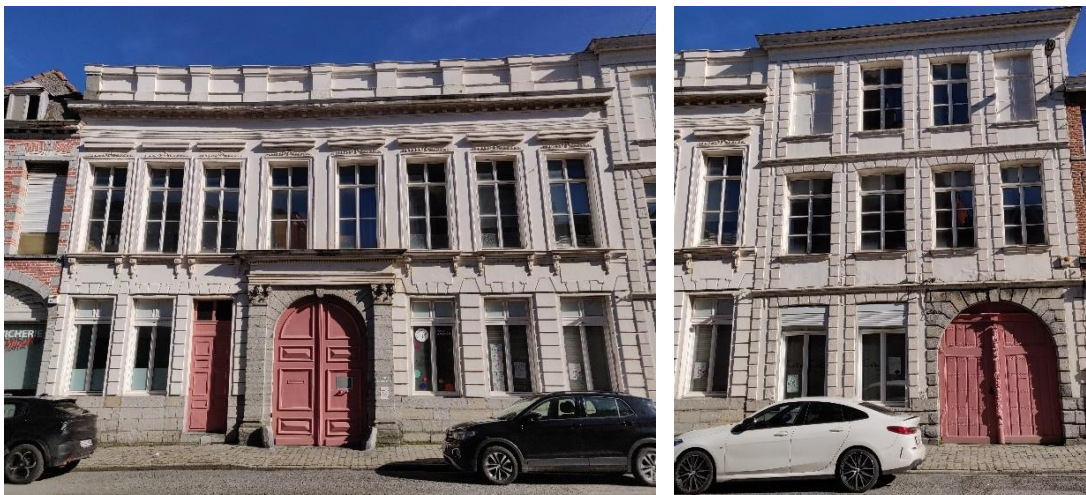
Façades actuelles des immeubles rue de la Madeleine n° 29 (gauche) et 27 (droite) (Photos Baudouin Desclée 2026)
