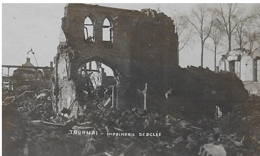
Ruines de l'imprimerie Desclée après le dynamitage de novembre 1918 (Photo Jules Messiaen)
