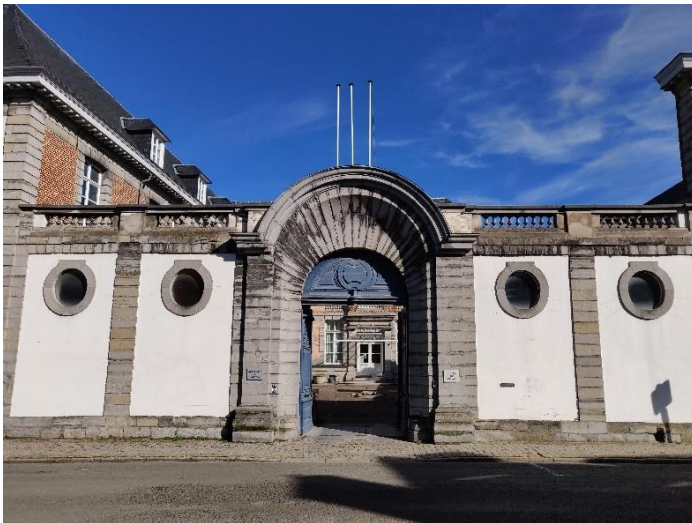
Façade actuelle du Tribunal du Commerce au n°41 de la rue Saint-Jacques (Photo Baudouin Desclée 2026)
