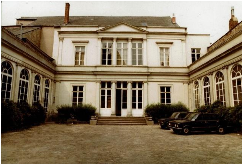
Cour intérieure du numéro 11 rue Saint-Jacques (Photo Bernard Desclée 1982)
