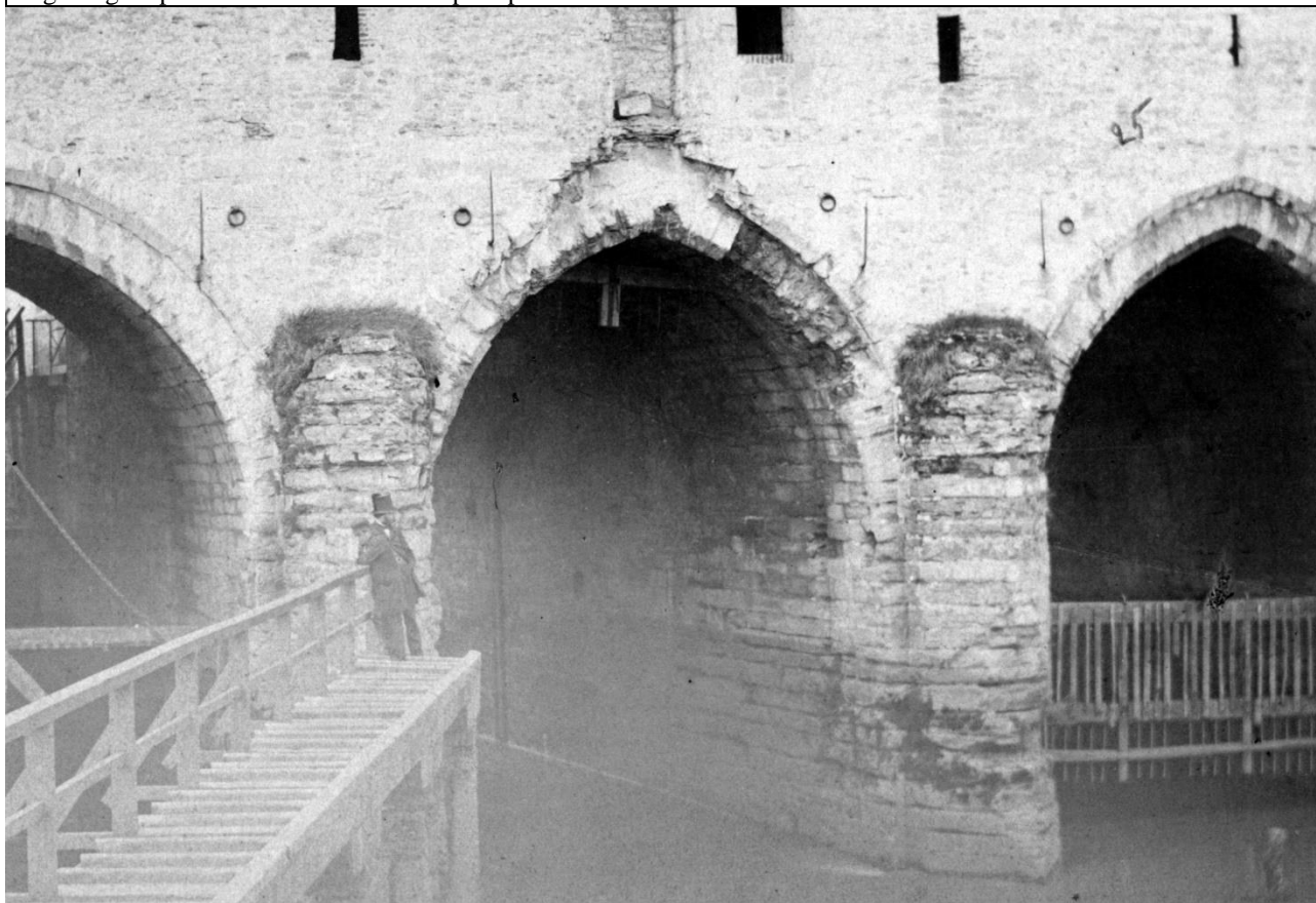
Fig. 5 : gros plan de l'arche centrale du pont permettant de visualiser le mur de soutènement
