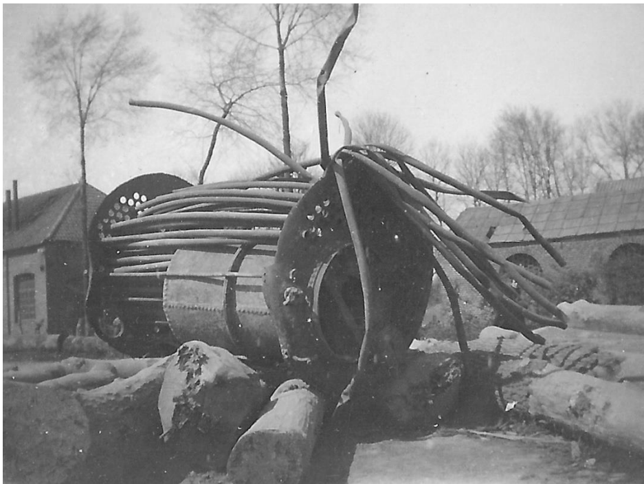
Photo RD 4552. Le corps de la chaudière tombé à 40 m de la rive.
