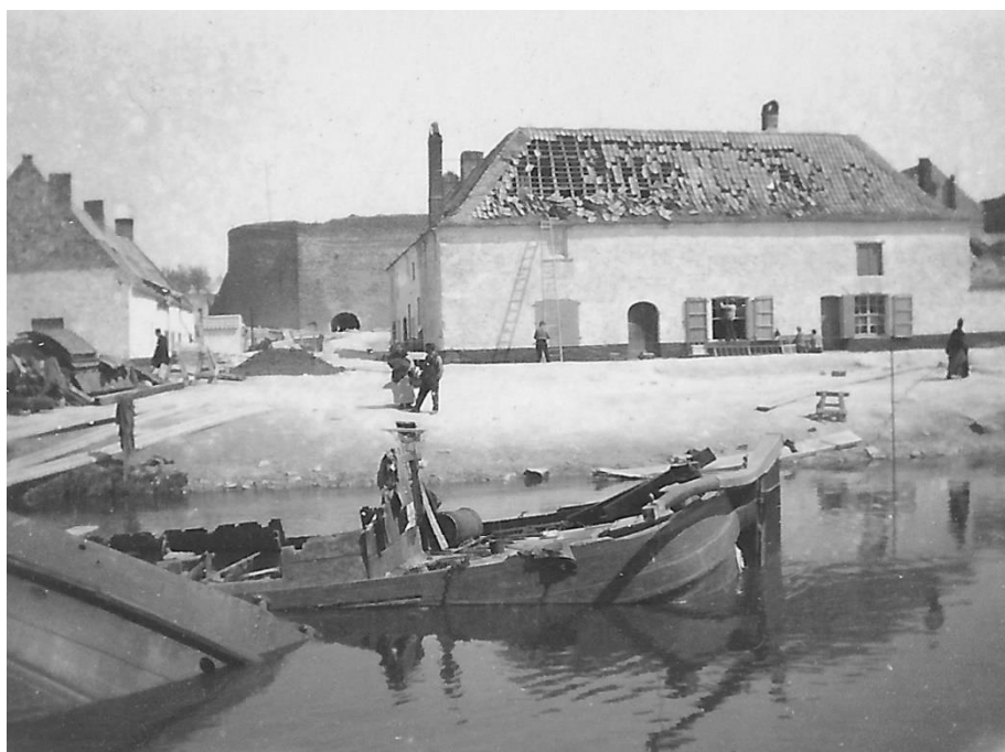
Photo RD 4554. Dégâts aux maisons proches.
