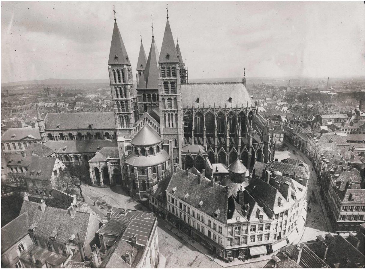
Photo RD 3057 du 4 5 1906, prise à partir du beffroi
