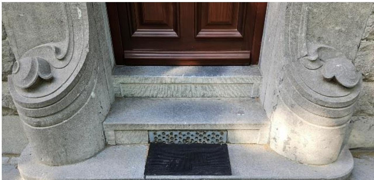
Photo 5 : seuil de porte encadré par deux structures en pierre bleue caractérisées par la ligne souple en « coup de fouet »
